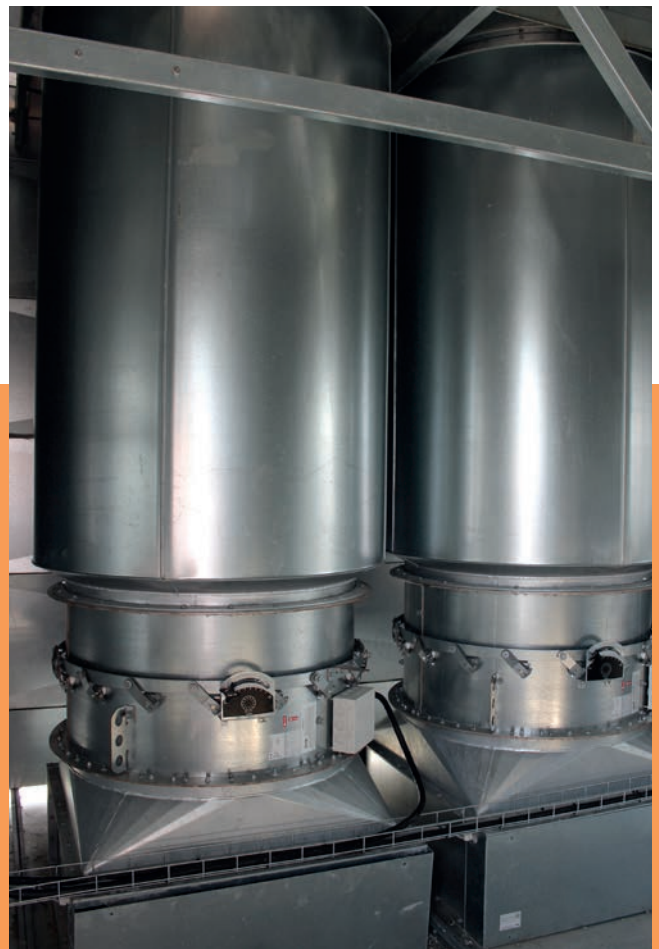
Odsávací ventilátory jsou namontovány přímo v přetlakové výfukové komoře. Uzavřená komora chrání ventilátory proti
