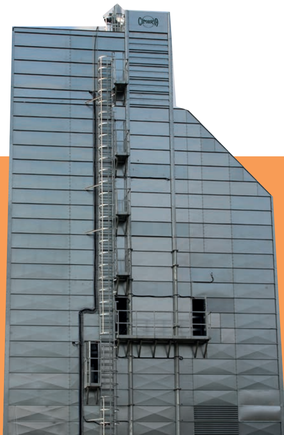
Pracovní plošiny pro kontrolu a snadné čištění, namontovány ve vzdálenosti 2,5 m.
